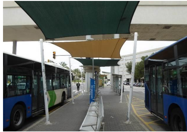
Zona de parada amb lones de protecció a l'aeroport de Palma de Mallorca.
