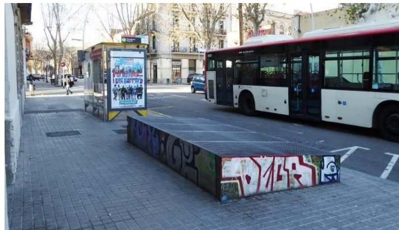
Exemple d'una reixeta de ventilació elevada a Barcelona. Font: Cinesi
