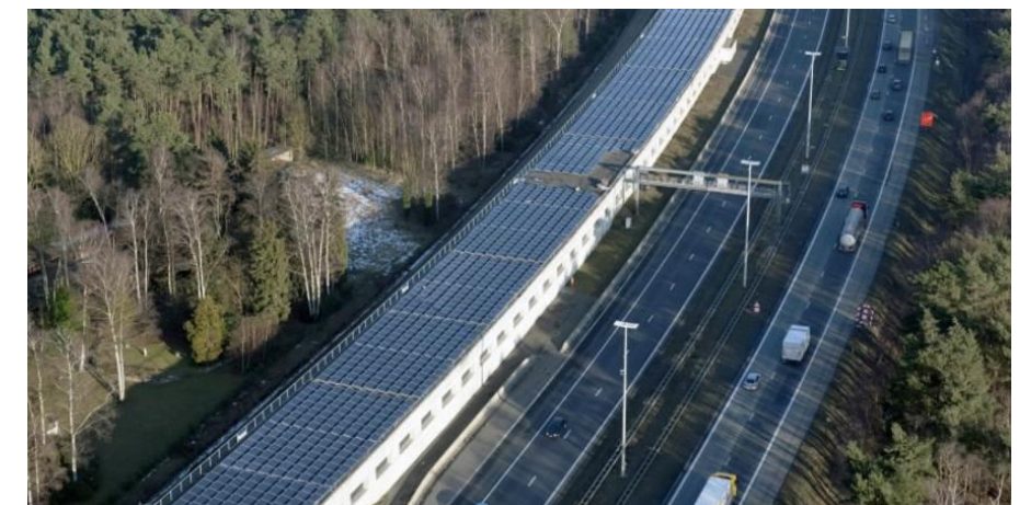
Túnel solar construït a Bèlgica.
