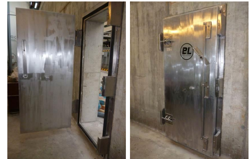
Exemple de portes impermeables a l'aigua.
