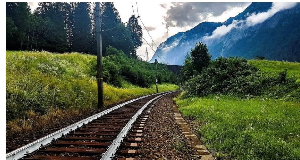
Figura 1.3. Raïls pintats de blanc de la xarxa ferroviària d'Àustria (ÖBB).
