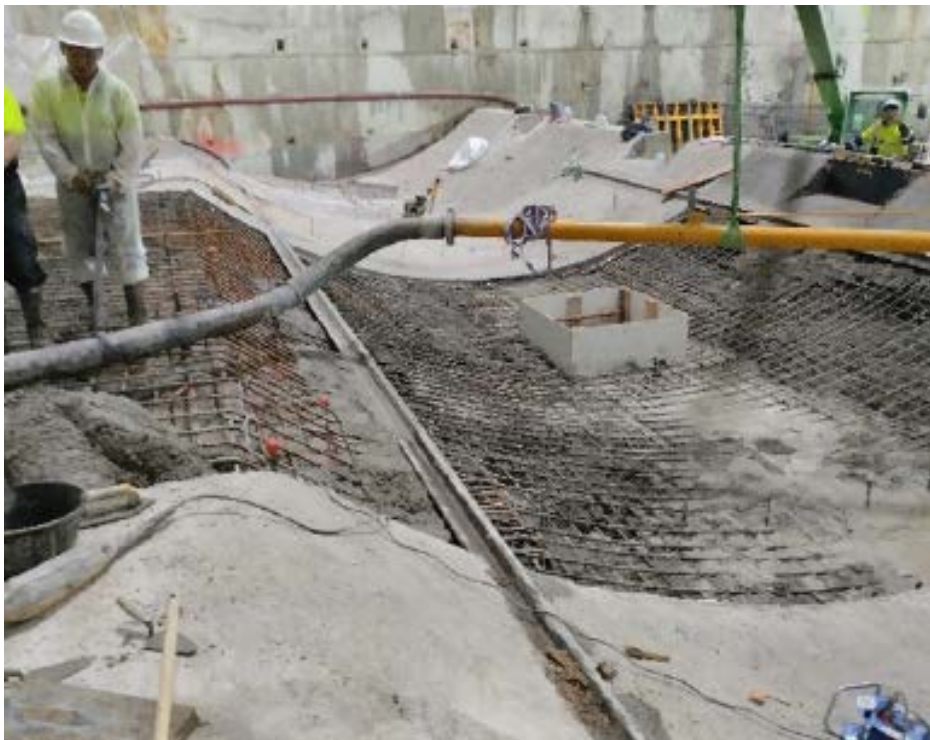
Figura 1. Formigonat bressol per la tuneladora TBM a Mandri
