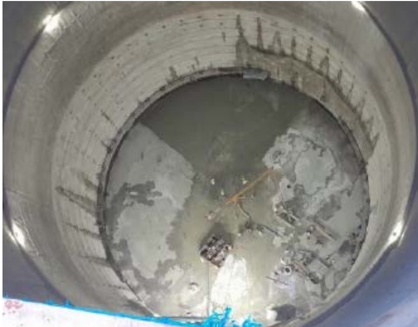
Figura 2. Llosa de fons formigonada. Mandri
