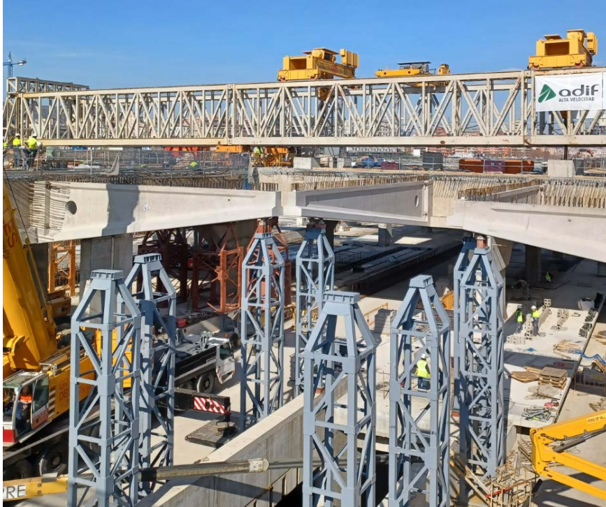
Figura 11. Muntatge de la coberta
