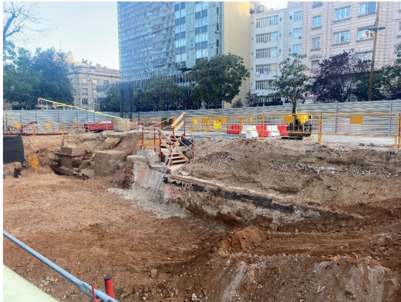
Figura 3. Obres a Gala Placídia
