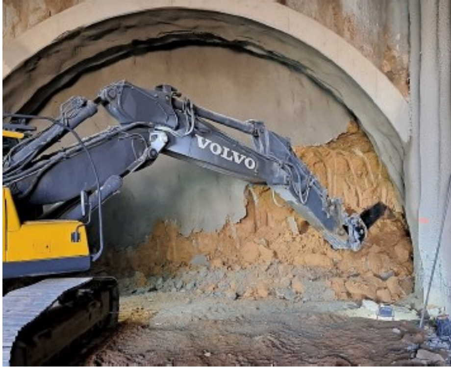
Figura 11. Construcció del túnel a Sant Feliu de Llobregat
