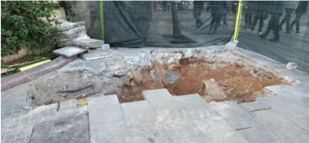
Figura 3. Treballs de cales a plaça Espanya
