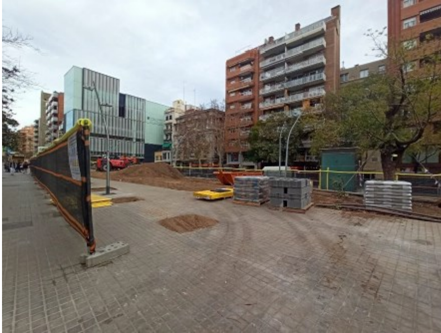
Figura 4. Actuació a Gal·la Placídia (estació de Gràcia)
