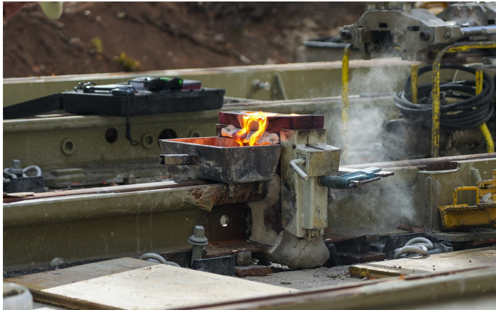
Figura 5. Darrera soldadura del carril fase 1
