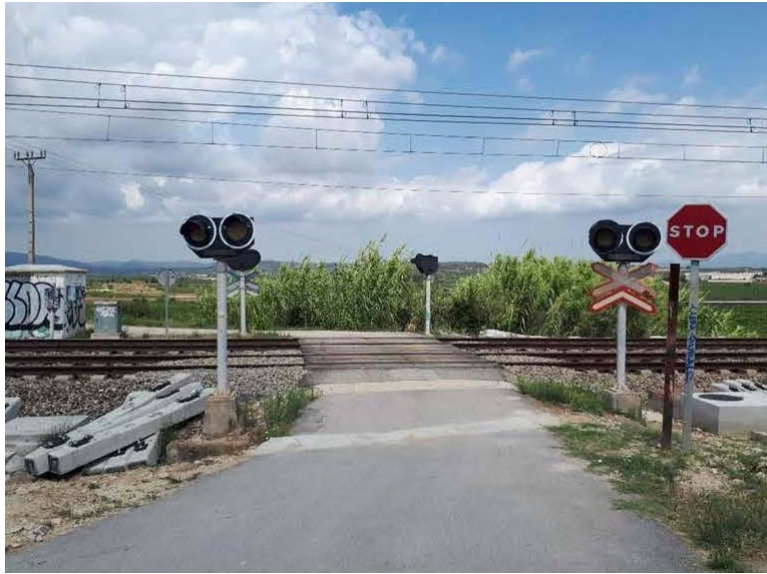
Figura 9. Pas a nivell de Subirats
