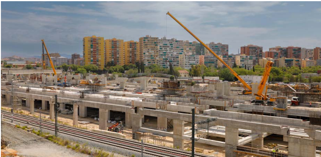
Figura 5. Treballs a l'estació de La Sagrera
