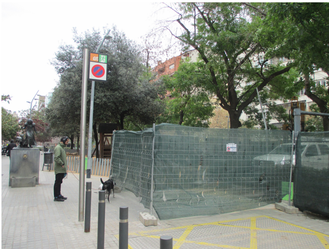
Treballs previs al Sud de Gal·la Placidia. Perllongament L8
