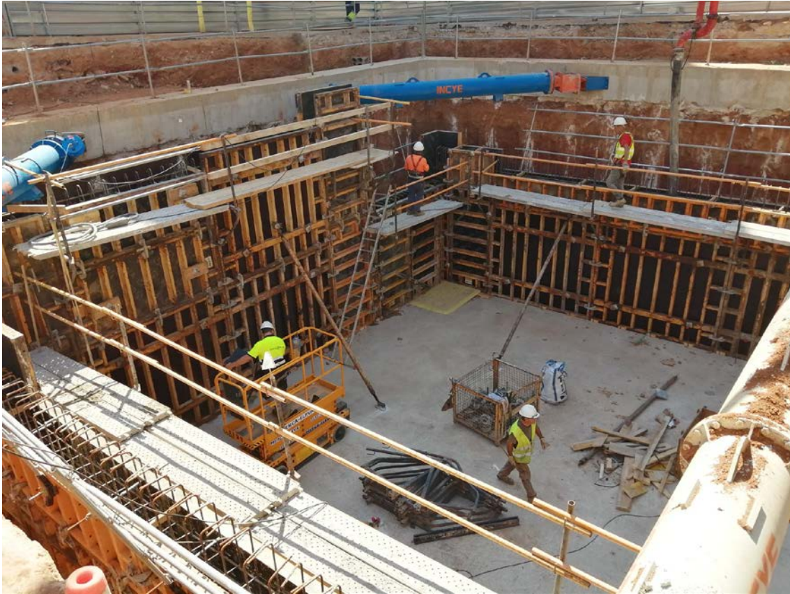
Construcció de la subcentral al carrer Nàpols - Diagonal
