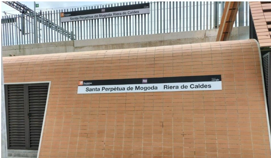
Nova estació de Santa Perpètua de la Mogoda Riera de Caldes
