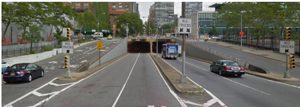
Figura 28. Exemple de senyalització per a camions confusa.
