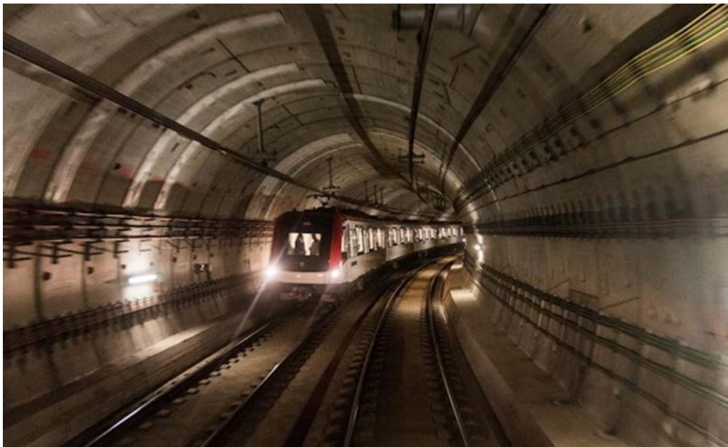
Figura 5. Túnel de metro
